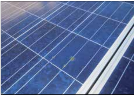
Eine Wärmebildkamera wird Defekte in Zellen als heiße Stellen erfassen, die das Solarmodul langfristig beschädigen können.
